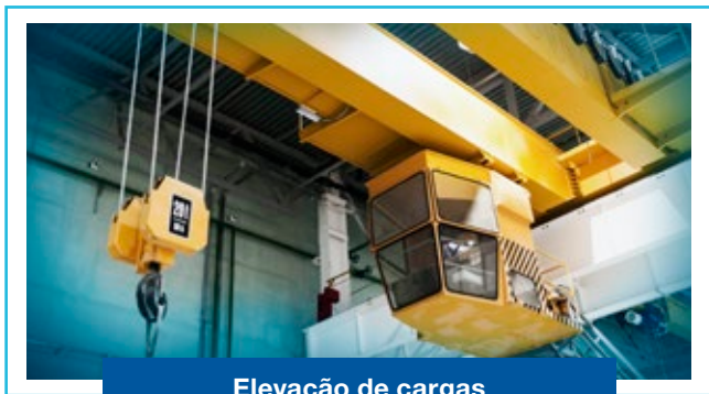
Elevação de cargas
